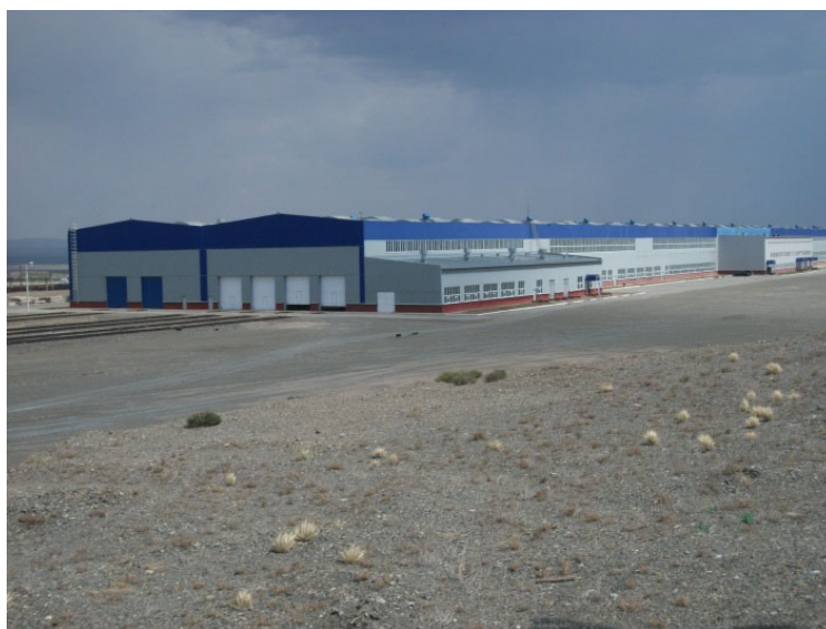
Рис.1. Пункт перестановки вагонов
