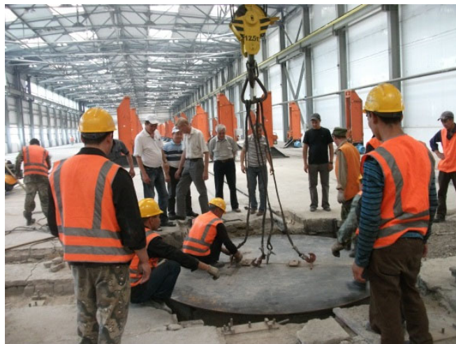
Рис.10. Монтаж поворотного круга
