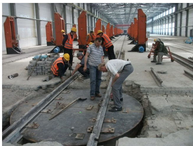
Рис.11. Установка рельсов на поворотный круг
