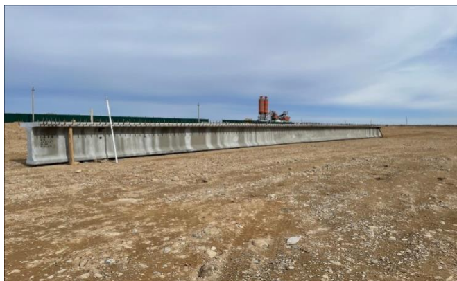
Рисунок 1 – Общий вид мостовой балки ВТК-33у
