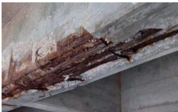
Рисунок 1 – Ухудшение конструктивных характеристик железобетонной конструкции, вызванное коррозией арматуры
