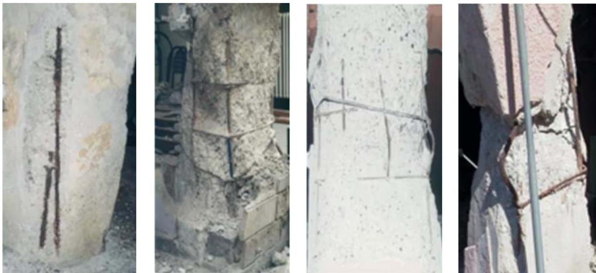
Рисунок 2 – Коррозия элементов ЖК, поврежденных во время землетрясения 1999 года в Измире, в Турции
