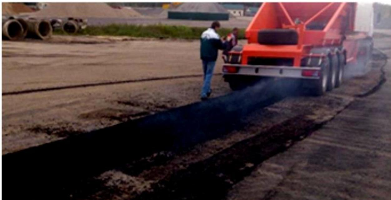
Рисунок 1 – Автосамосвал с донной разгрузкой в процессе работы
