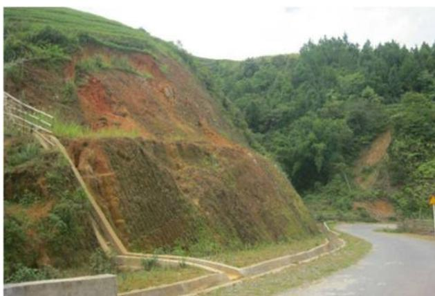
Рисунок 2 – Сооружение на откосе сети из боковых и магистральных каналов
