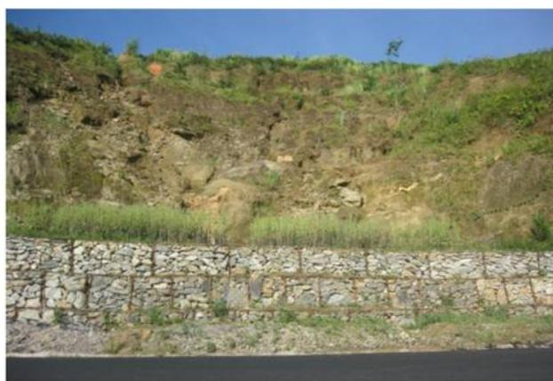
Рисунок 3 – Габионная подпорная стенка
