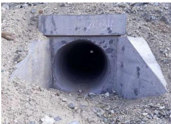
Рисунок 1 – Выходной оголовок водопропускной трубы
