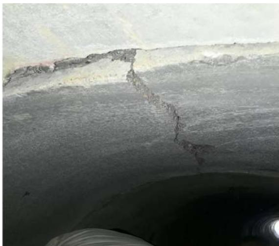
Рисунок 3 – Разрушение растянутой зоны бетона звеньев водопропускной трубы
