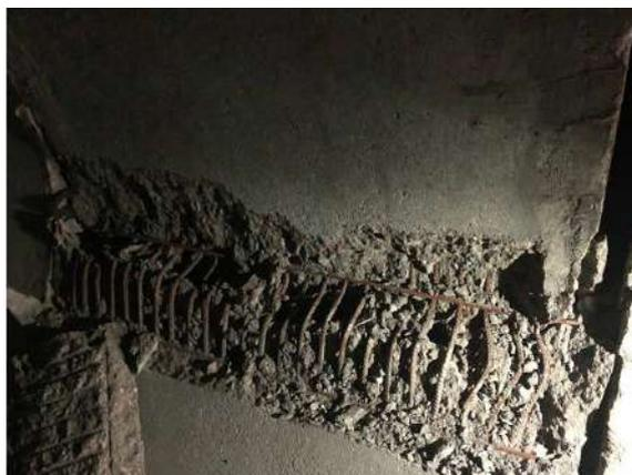
Рисунок 2 – Разрушение сжатой зоны бетона звеньев водопропускной трубы
