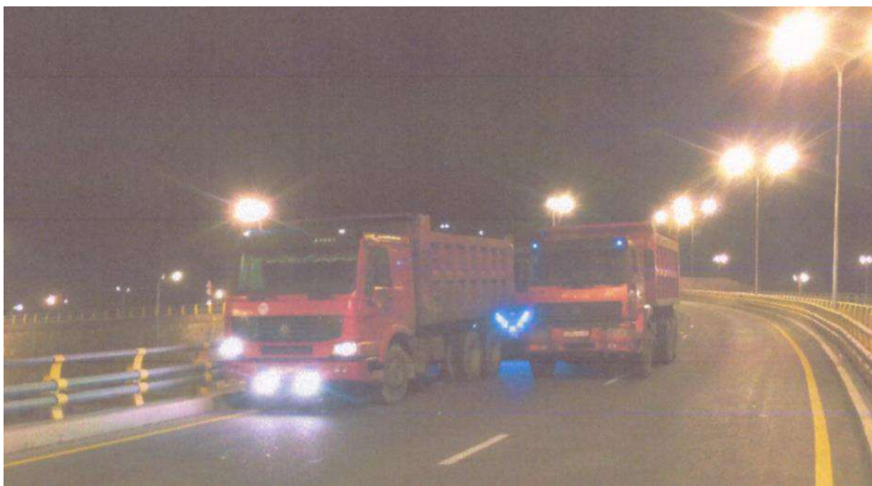
Рисунок 1 – Загружение пролетного строения автосамосвалами
