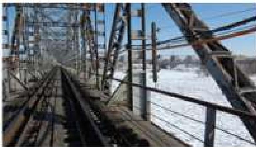
Рисунок 6 – Мостовое полотно на русловом пролётном строении
