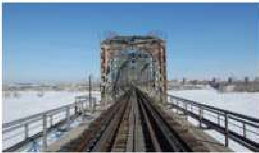
Рисунок 5 – Мостовое полотно на береговом пролетном строении
