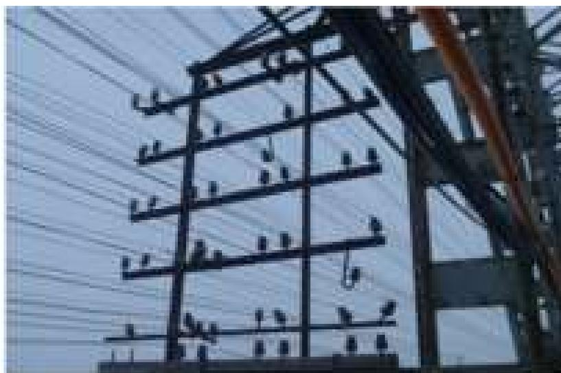
Рисунок 8 – Воздушные линии связи, закрепленные на ферме
