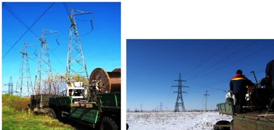
Рисунок 2 – Бригада на линии осуществляет монтаж ВОЛС на ЛЭП
